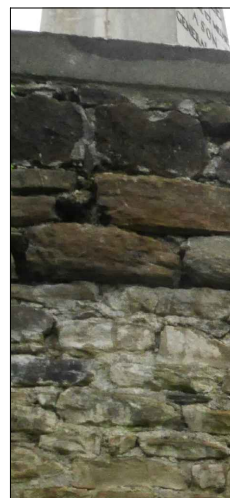
Bandeau en moellons de schiste horizontaux Blende aus horizontalen Schieferbausteinen
