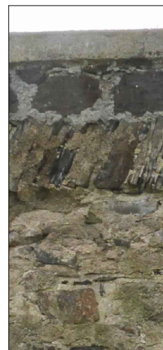
Bandeau en moellons de schiste verticaux Blende aus vertikalen Schieferbausteinen
