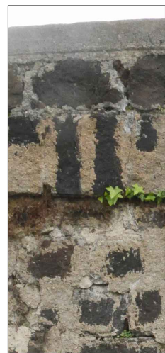
Bandeau en moellons de basalte Blende aus basaltbausteinen
